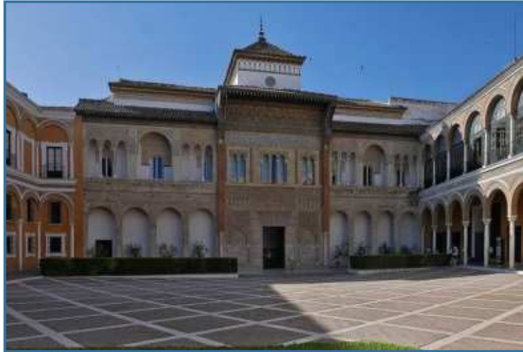
The Mudéjar façade of Pedro I's Palace from the Patio de la Montería.
