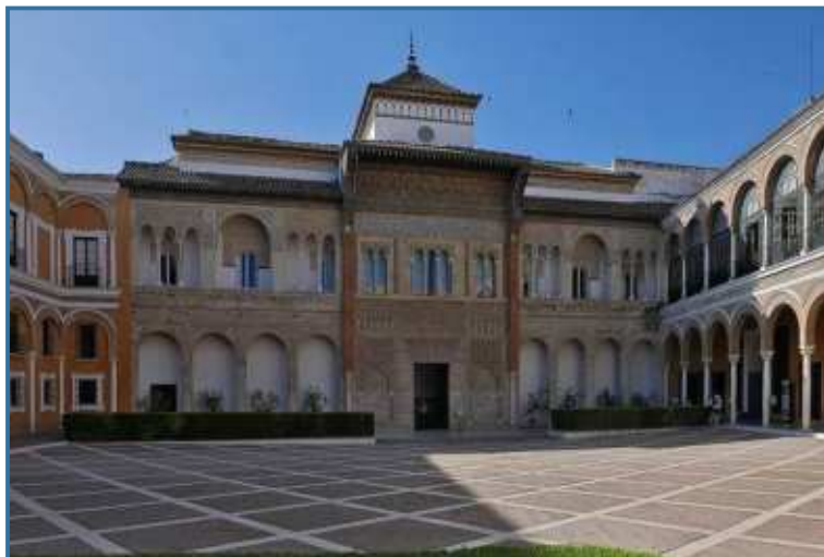
La façade mudéjare du palais de Pierre Ier depuis le Patio de la Montería.
