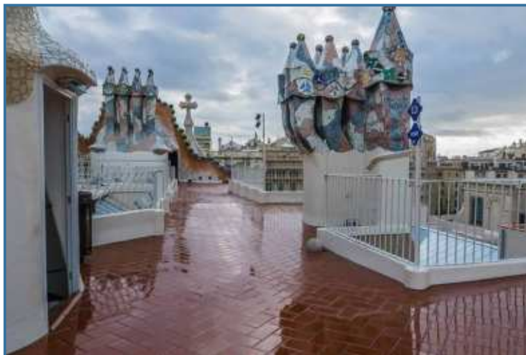
Les cheminées de trencadís et le toit écaillé de la terrasse.
