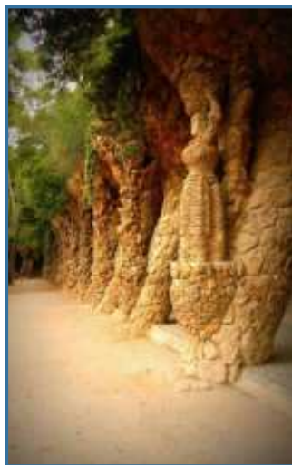
Les portiques aux colonnes inclinées semblent jaillir du flanc de la montagne.
